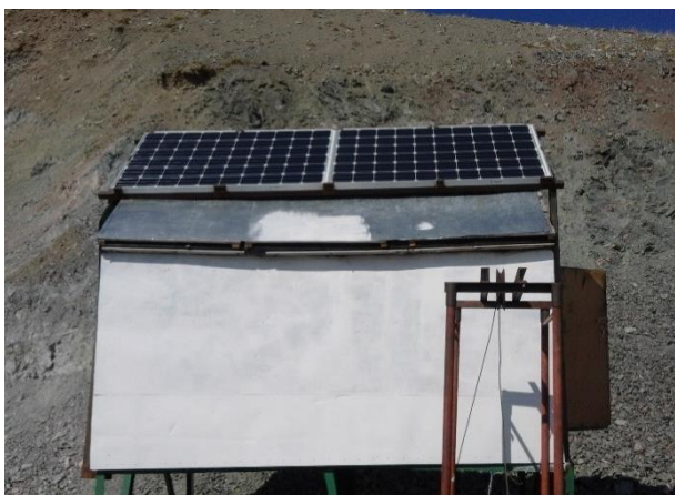
Рисунок 1. Специальное помещение с установленными в его крыше солнечными панелями
